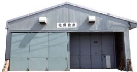
各種メーカーの蒸気乾燥炉
